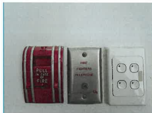
ภาพถ่ายที่ 2.2-11 อุปกรณ์แจ้งเตือนและป้องกันอัคคีภัย
