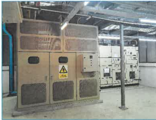
หม้อแปลงไฟฟ้าและระบบควบคุมไฟฟ้า MDB
