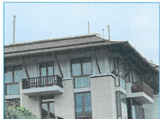
ภาพถ่ายที่ 2.2-14 เสาล่อฟ้า สายล่อฟ้า
